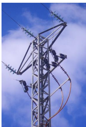
Figura 9. Instalación eléctrica para acometida de la bomba
