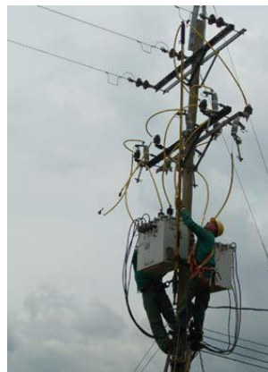
Figura 9. Instalación eléctrica para acometida de la bomba
