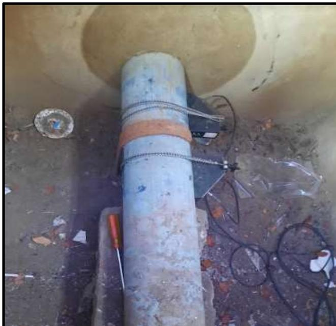
**Figura 2.8 Instalación de caudalímetro en sector piloto N72-1006**
