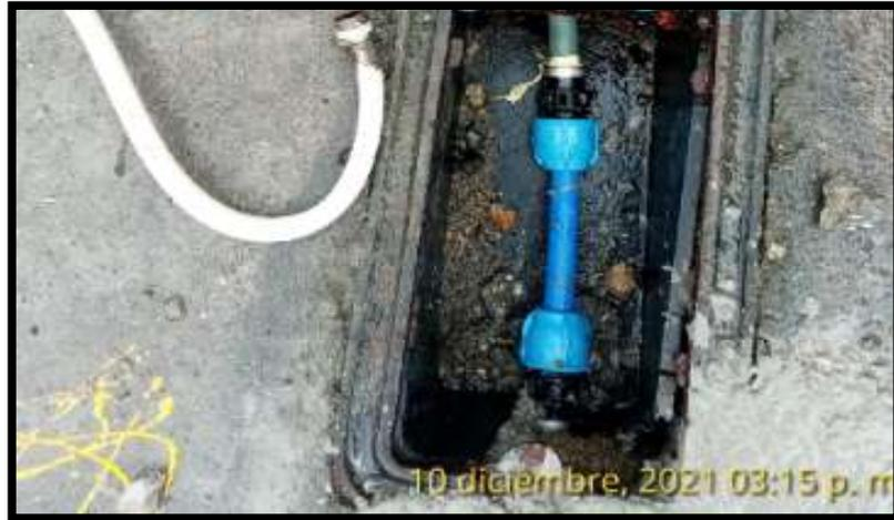
**Figura 2.2 Ejemplo de pérdida aparente mediante guía directa**
