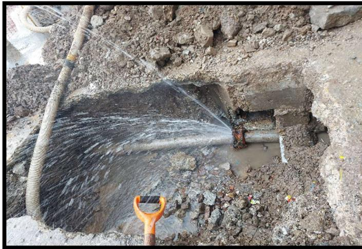
**Figura 2.1 Ejemplo de pérdida real mediante fuga en red**
