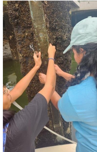
b. Instalación de sensor de presión
