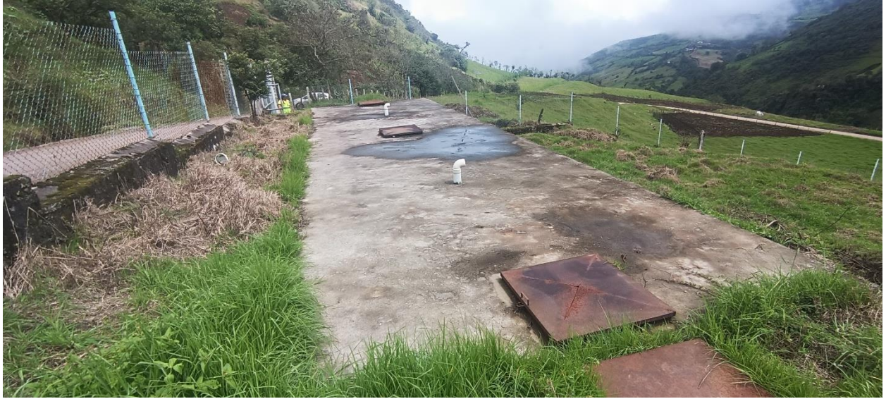
Figura 2. Estado actual de la PTAR.
