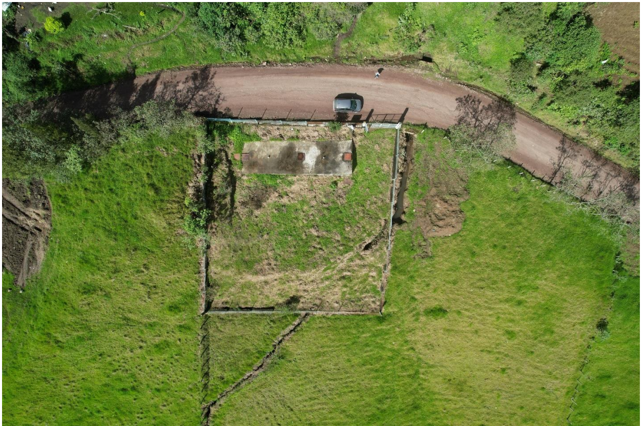
Figura 3. Vista aérea de la PTAR.
