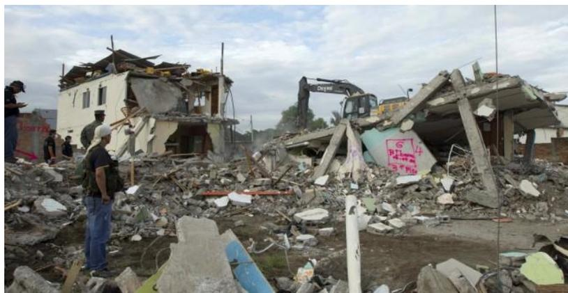
**Figura 3.3.-** Imagen de RCD de demolición terremoto Ecuador 2016
