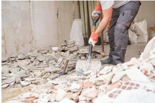
**Figura 3.2.-** Imagen de RCD de Remodelación
