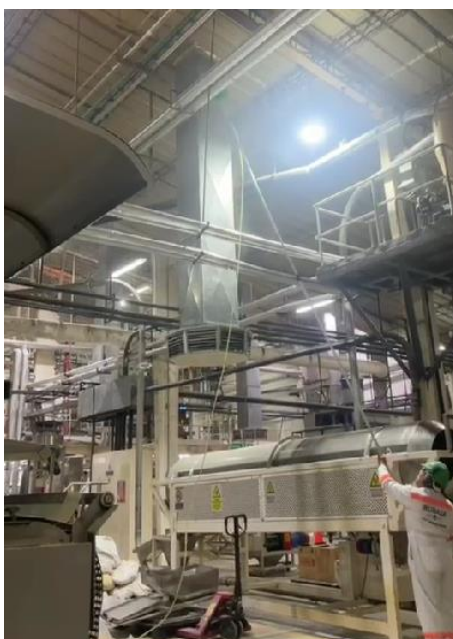
Figura 1.1: Limpieza de canaletas y tuberías eléctricas con aire comprimido
