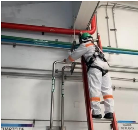
Figura 1.2: Limpieza de canaletas y tuberías eléctricas con paños y escobillas.
