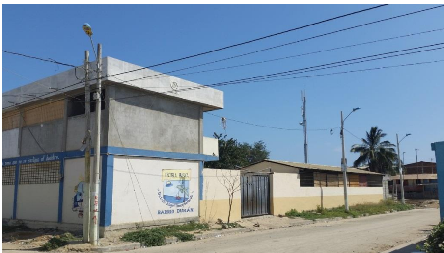
Figura 3.36 Lugar de Instalación de la Primera Sirena electrónica
