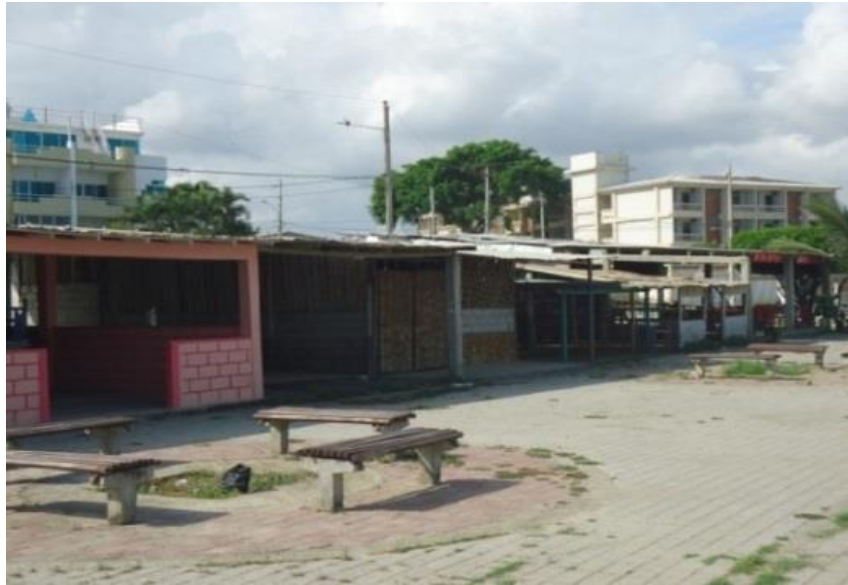
Figura 1.7 Edificaciones de la costa en la ciudad de Playas.
