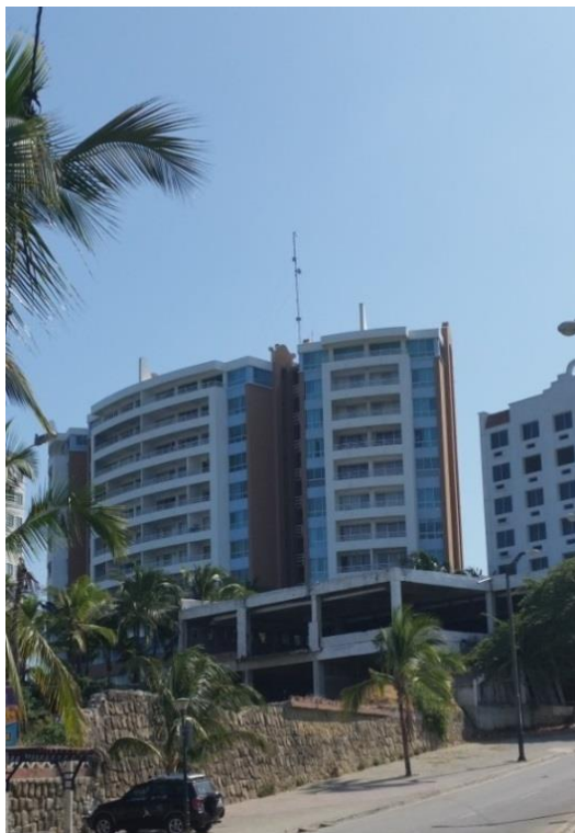
Figura 3.38 Lugar de Instalación de la Segunda Sirena electrónica
