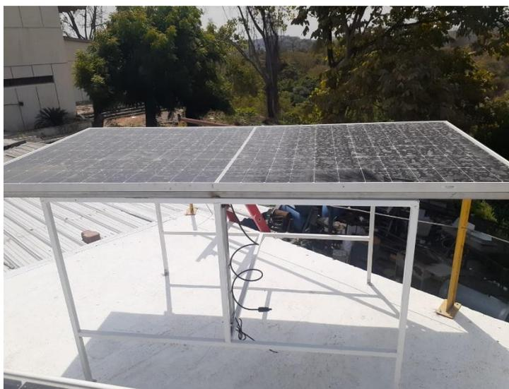
En esta Figura 2.2 se puede observar la instalación de un panel, que se repite para el conjunto, con un movimiento de inclinación al activarse el actuador lineal, mientras que a continuación, en la Figura 2.3 se muestra la ubicación del actuador lineal en la estructura.
