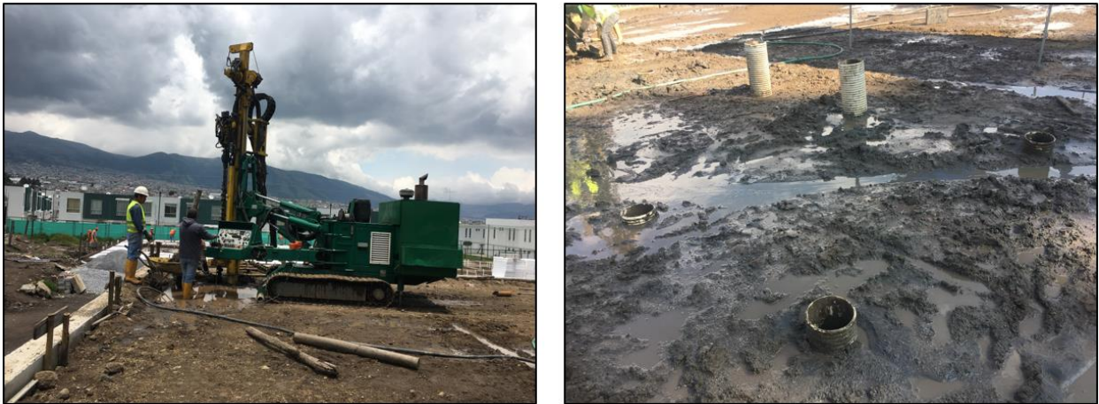
Figura 2.4 Construcción de micropilotes, cortesía del Ing. Hugo Torres proyecto "Terranova 4".
