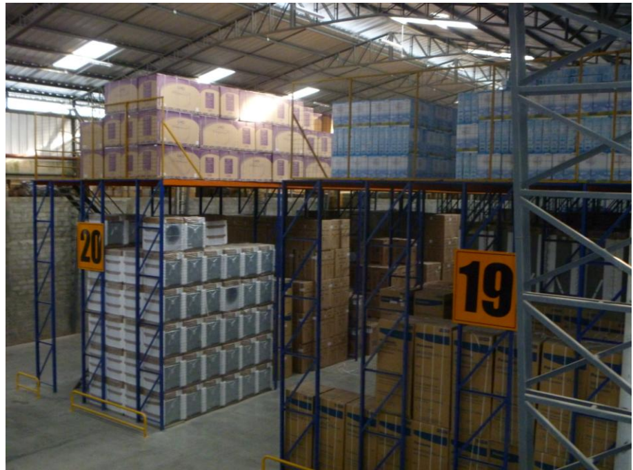
Figura 4.7 Vista real de los mezanines de apilamiento libre.
