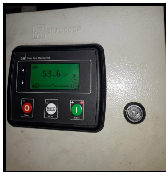
Figura 3.11 Potencia del motor después de mantenimiento
