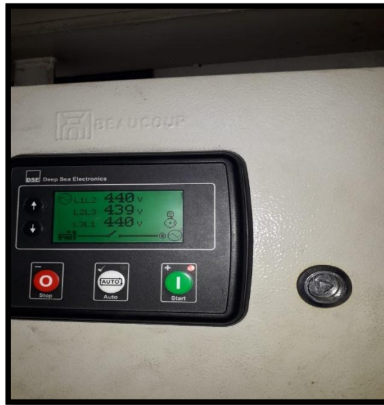
Figura 2.3 Medición del voltaje Línea a Línea
