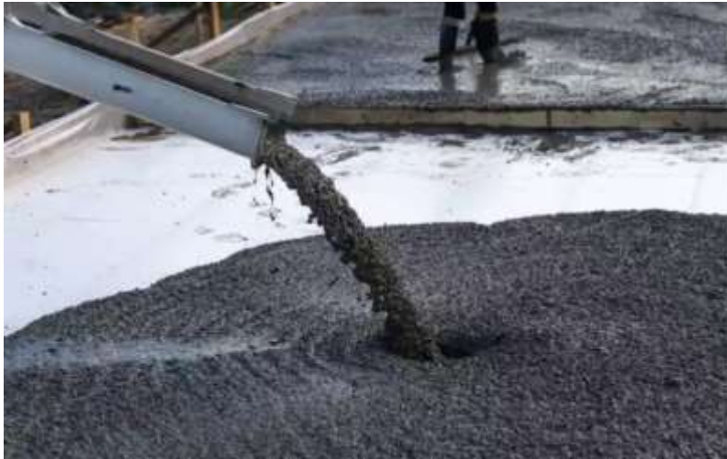
Figura 2. Vaciado de Concreto con Bomba
