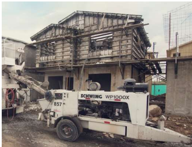
Figura 2. Vaciado de Concreto con Bomba
