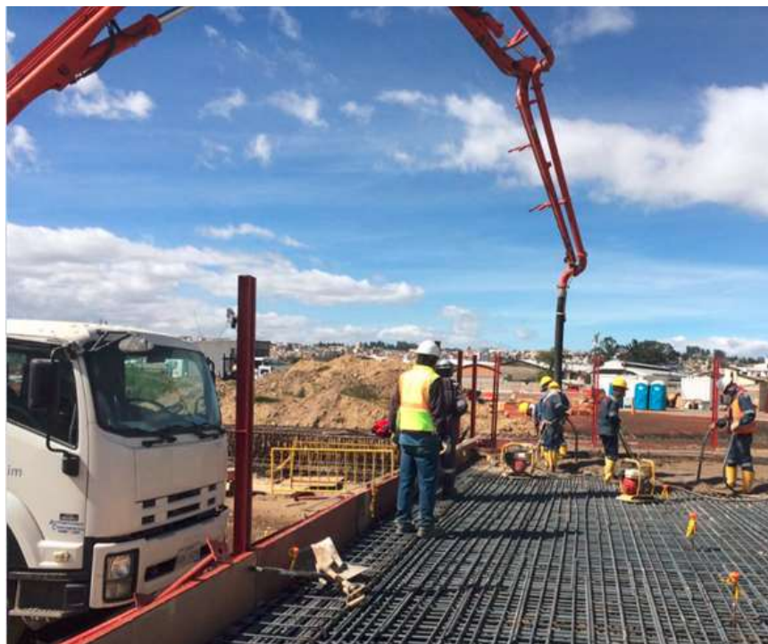
Figura 3. Vaciado de concreto con Autobomba 5
