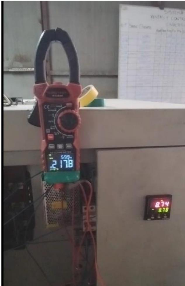
**Figura 6.18. Análisis del voltaje de salida del regulador, tomada de la fase b y el neutro del sistema, para verificar la relación que muestra el controlador con el valor real de voltaje y se confirma el correcto funcionamiento, ya que el indicador en rojo esta próximo al punto de operación 380VAC y 217.8VAC corresponde a 377.24VAC línea a línea.**
