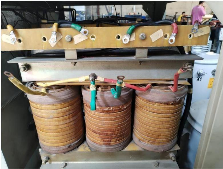
**Figura 6.3. Conexión de transformador trifasico, lado secundario con los aisladores de entrada y aisladores de salida y lado primario con las escobillas de autotransformador variable.**
