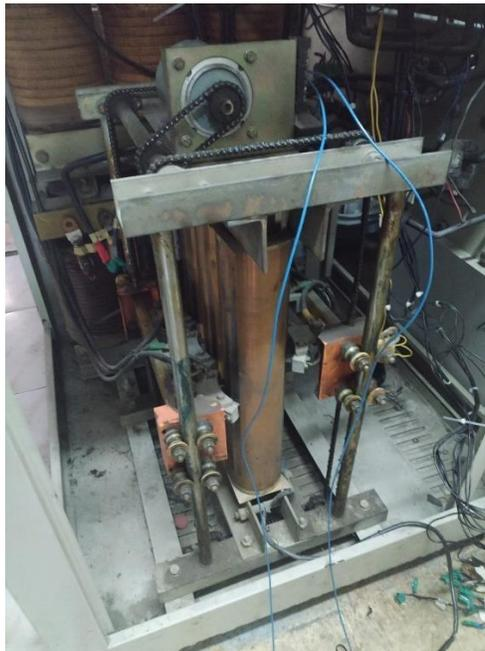
**Figura 6.4. Conexión de escobillas con el lado secundario del transformador, conexión de alimentación con los aisladores de entrada con netro y conexión de motor sincrónico a sensores final de carrera.**
