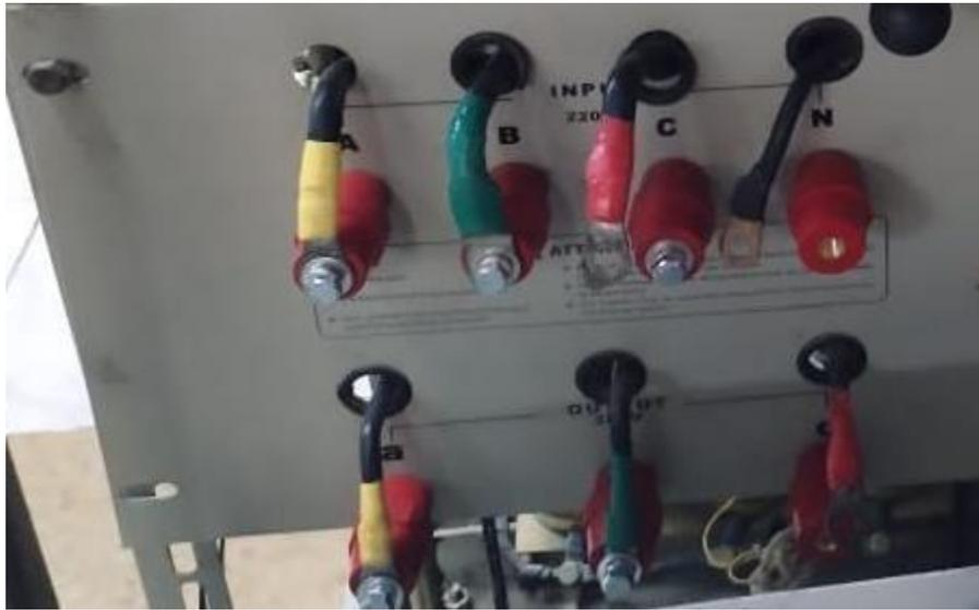
Figura 6.5. Aisladores de entrada fase A, B, C y N, Aisladores de salida a, b y c
