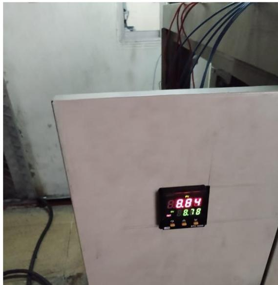
**Figura 6.11. Montaje del controlador BTC9300 en el gabinete del regulador de voltaje.**
