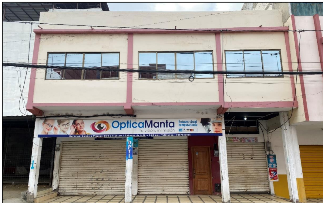
Ilustración 1. 2 Fotografía Exterior de la Edificación (Rivera, J., 2024)
