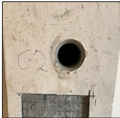
Ilustración 2. 6 Núcleo de 50 mm de diámetro extraído de columna (Rivera J., 2024)
