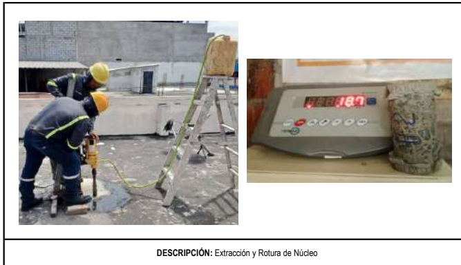
DESCRIPCIÓN: Extracción y Rotura de Núcleo
