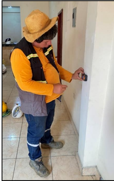
Ilustración 2. 8 Detección de armaduras con Pachómetro (Rivera J., 2024)
