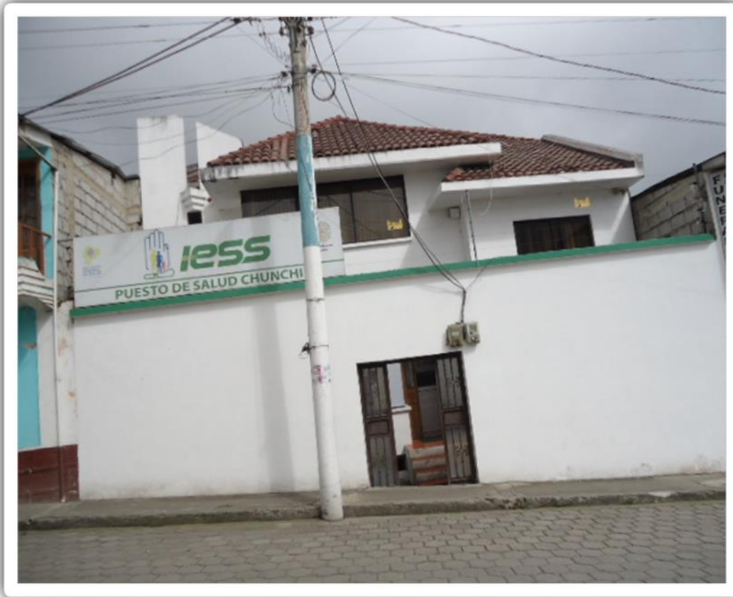
Foto: Instalaciones del Puesto de Salud Chunchi
