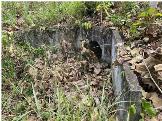
*Imagen 2.1 Tubería desagüe aguas lluvias proveniente de la carretera (Morales & Taipe, 2022)*
