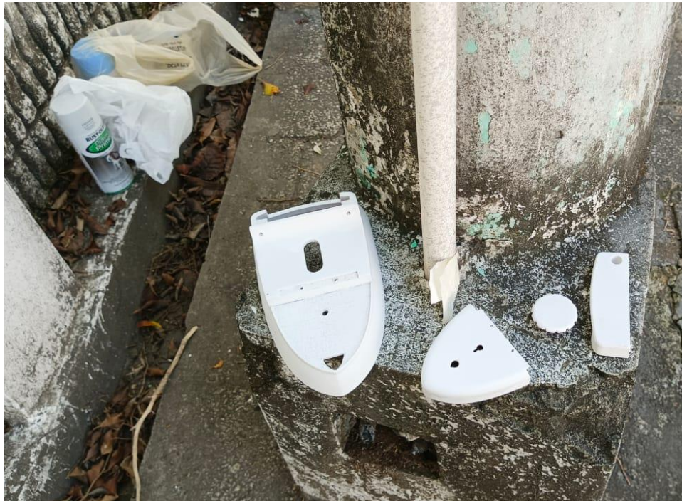
Figura 4.6.3 Aplicado de sellador, pintura y laca.
