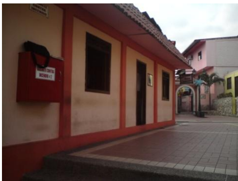
FIGURA 8. Gabinetes contra incendios
