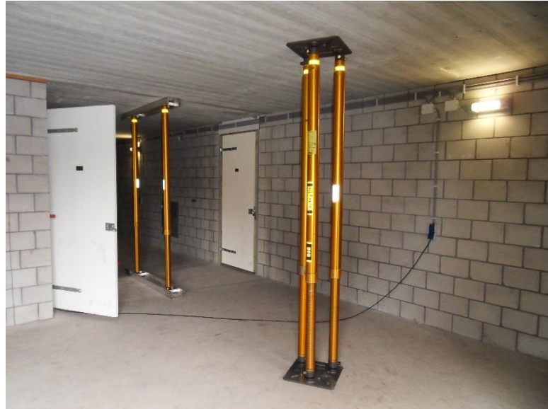
Gráfico 3.17: Ejemplo de apuntalamiento con estructura metálica de cualquier elemento a rehabilitar.
