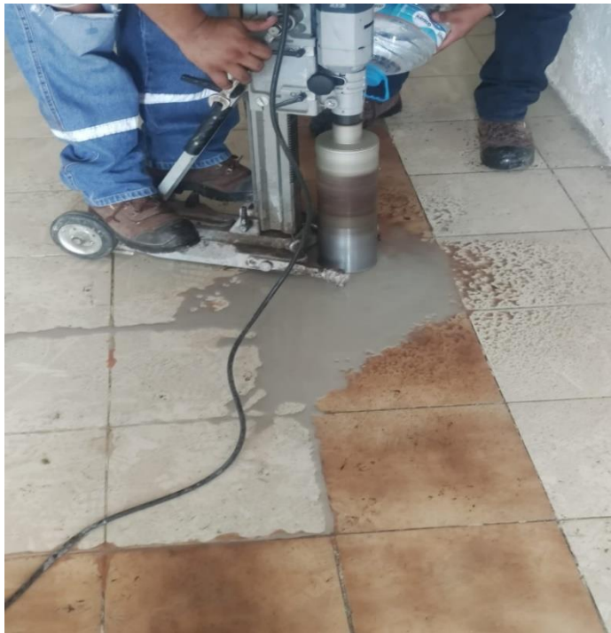
Gráfico 2.10: Extracción de núcleo correspondiente a la Primera Planta Alta
