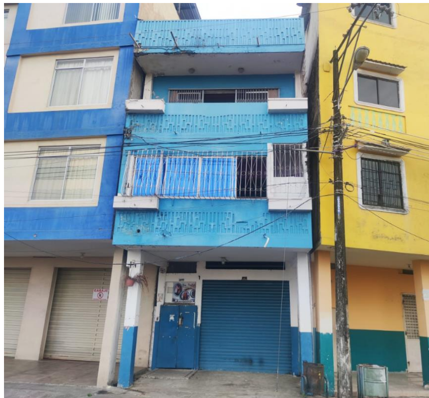
Gráfico 2.7: Imagen de Fachada Frontal tomada en sitio.
