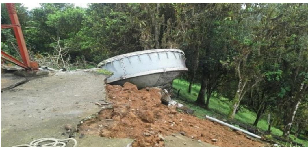
Figura 1.2: Desnivel y cuarteamientos en la base de la torre auto- soportada de telecomunicaciones, CNT-Cojimies [1]
