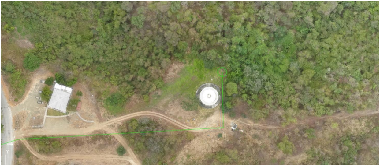
Figura 3.1 Ubicación de tanque elevado para riego por goteo
