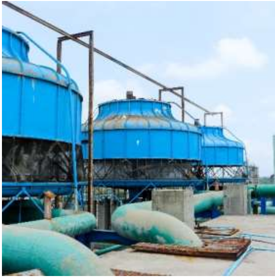
Figura 19 Sistema Agua – Agua (Hidrónico).
