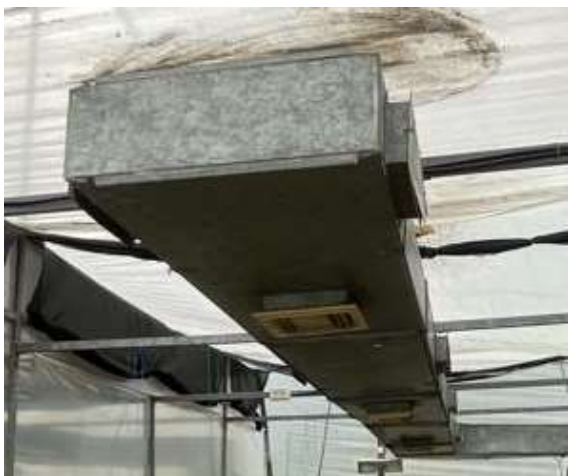
Figura 18 Sistema Aire – Aire (Aires Acondicionados).
