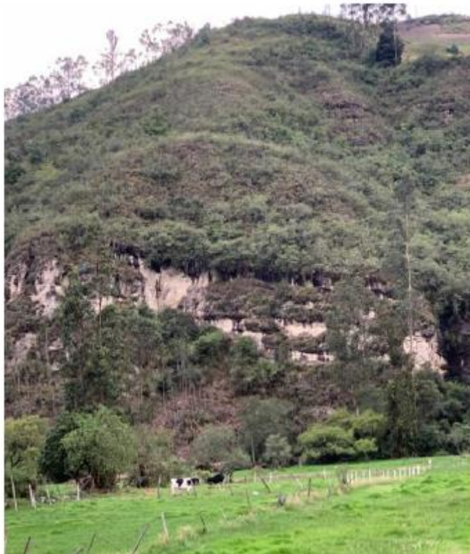
Figura 1-3: Talud del km 5 de la vía Cuenca-Estación de Cumbe
