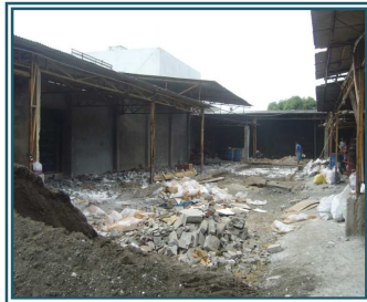
Infraestructura del local
