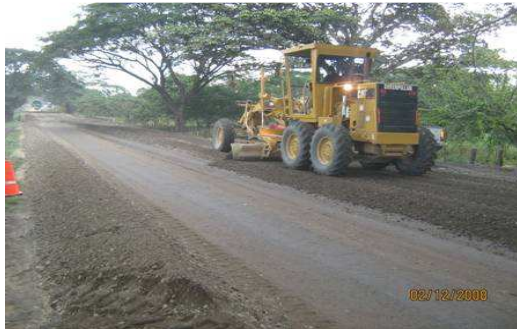
Fig. 5.3 Acabado de la capa de base.
