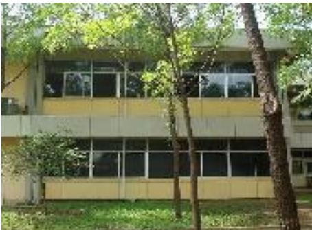
BLOQUE DE AULAS
