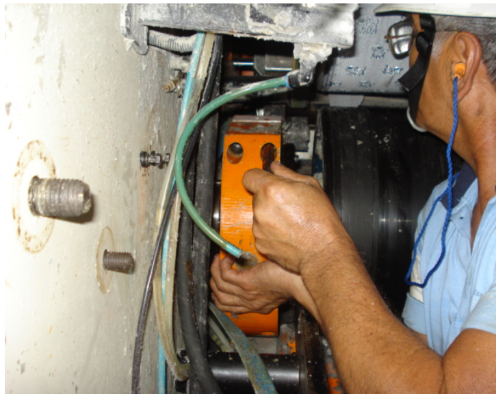
FIGURA 3.9 MECÁNICO AFLOJANDO LAS BRIDAS DE LOS RODAMIENTOS
