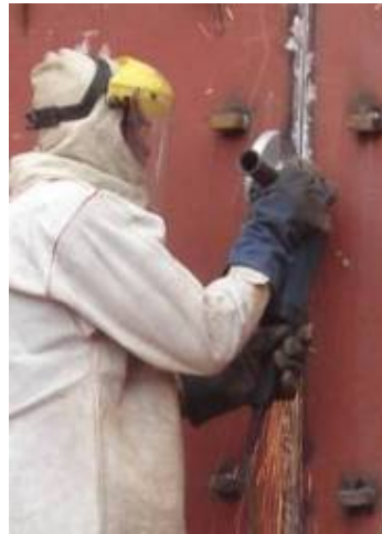
Figura 4.35(b) Limpieza soldadura vertical del cuerpo
