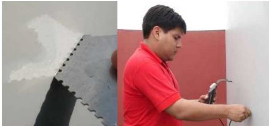
Figura 4.25 Medición de espesores en húmedo y en seco
