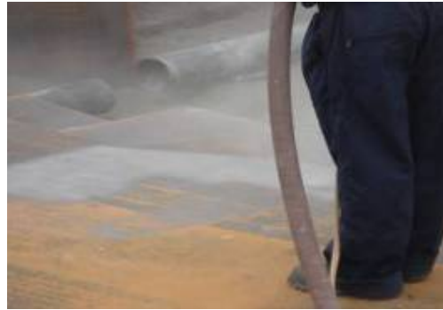
Figura 4.22 Chorro abrasivo con arena (FONDO)
