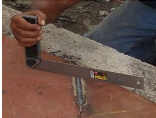
Figura 4.29 Soldadura en el fondo
