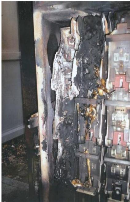
**Fig. 2.5. Después de un arco eléctrico.**
