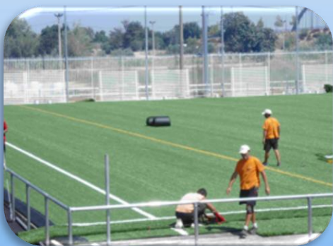
Colocación de líneas
