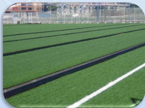
Tendido de Rollos
