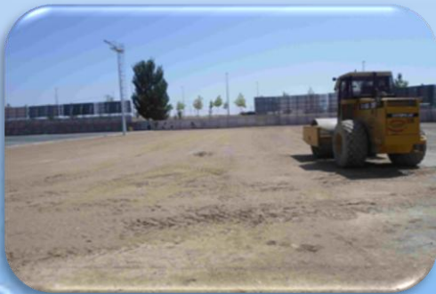
Compactado y Nivelación
