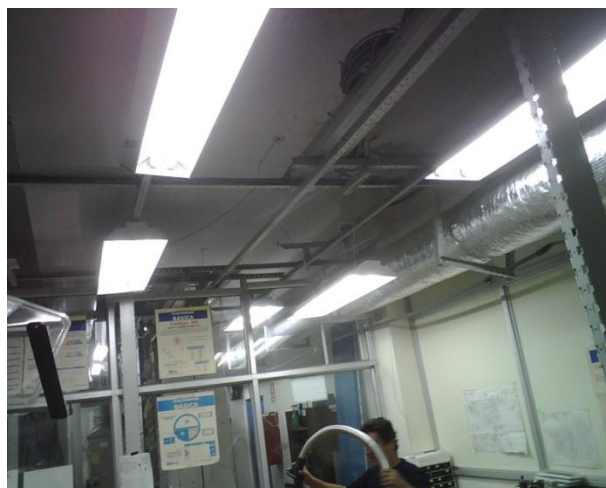
Figura 4.2 Vista de la Altura del Taller
