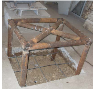
FIGURA 1.24. ARMADURA DE CIMENTACIÓN
