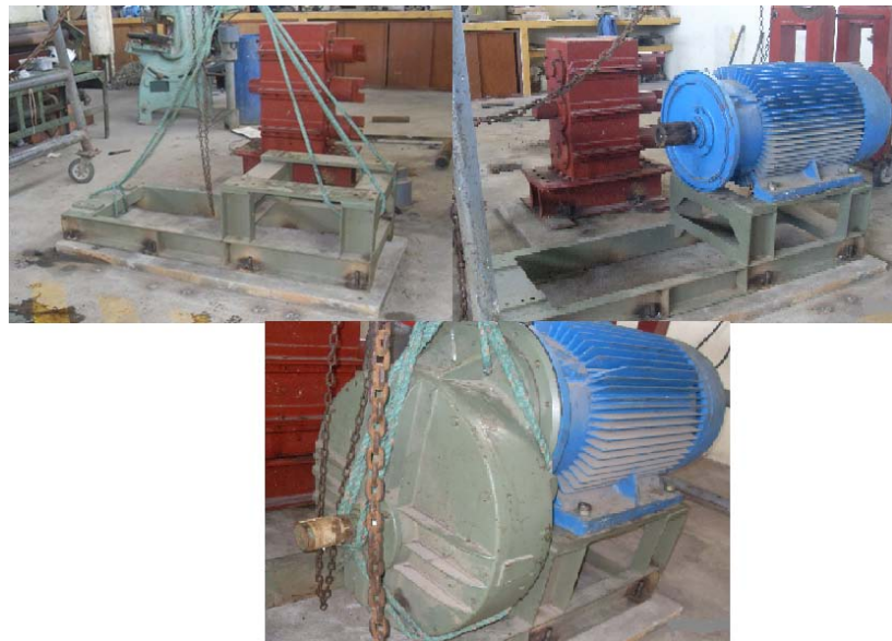
FIGURA 2.37. MONTAJE DEL MOTO-REDUCTOR
