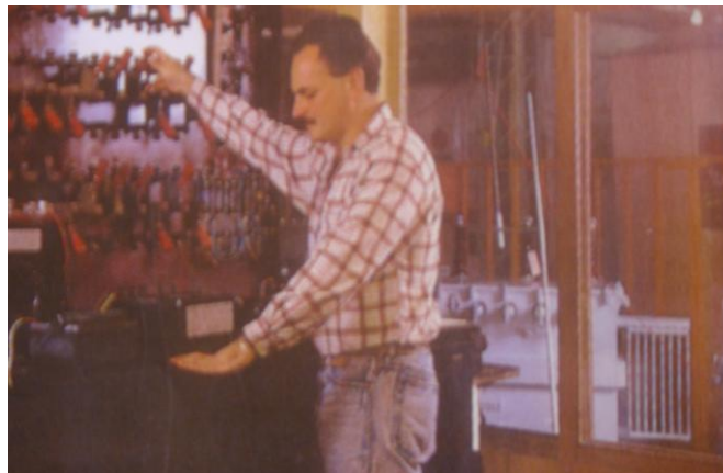
FIGURA 3.2 BANCO DE PRUEBAS DE LOS TRANSFORMADORES
