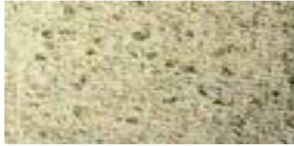
El sopleteado abrasivo o con arena se emplea para opacar la superficie encofrada, para dar uniformidad al color o para exponer el agregado del hormigón visto en estructura. Los grados de exposición que se obtienen con este tipo de acabado son:
