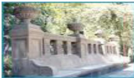
La piedra artificial precolada es una variante del hormigón visto premoldeado manufacturado para imitar la piedra tallada natural.
