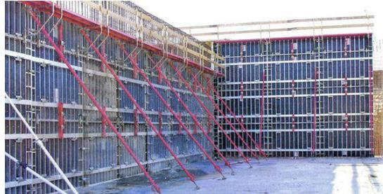
Las superficies de **acero** son impermeables y proporcionan un color uniforme. El revestimiento de acero debe ser lo suficientemente grueso para soportar la carga entre sus elementos de apoyo, con el fin de mantener las deflexiones dentro de límites aceptables.
