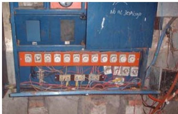
**Fig. 2.12.** Instalación en la que podría producirse una sobrecarga.
