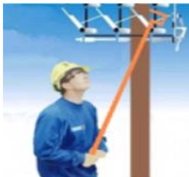
**Fig. 5.1. Desconexión del circuito.**
