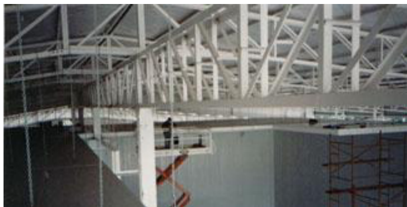
FIGURA 2. 2 ESTRUCTURA DEL TECHO DE LA CÁMARA.
