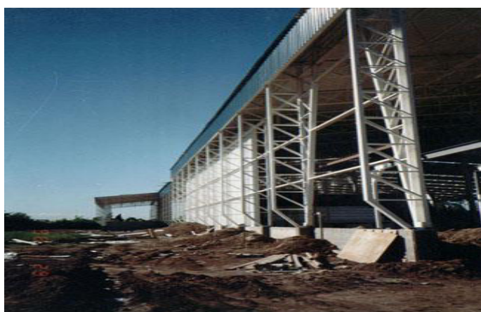
FIGURA 2.1 CERRAMIENTO VERTICALES DE LA CÁMARA.
