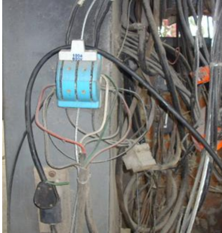
Fig. 7: Dispositivo de protección no empotrado [8]
