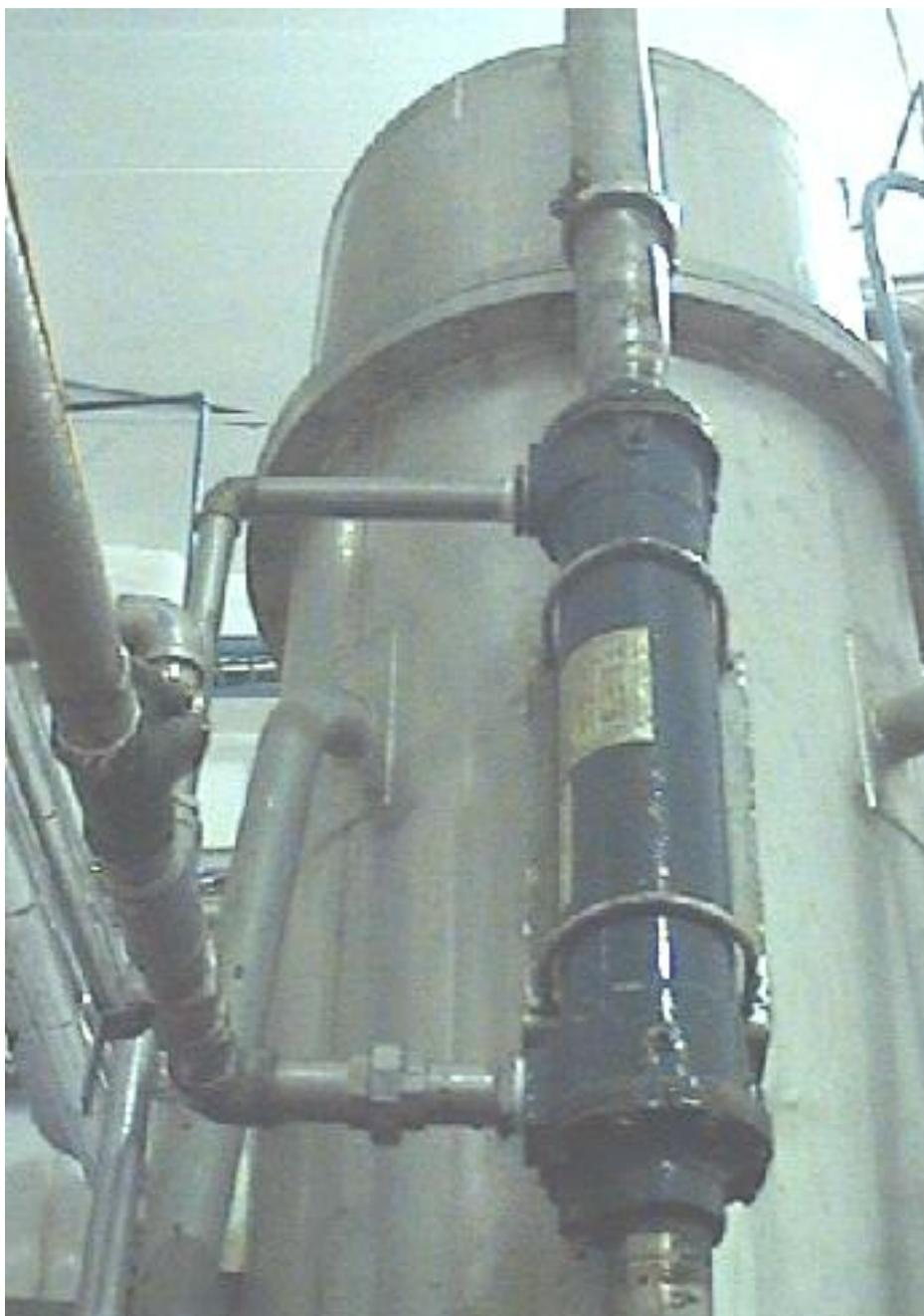
**FIGURA.2.3 ENFRIADOR DE AIRE EXTRAÍDO DE CÁMARA DE VACÍO ( INTERCAMBIADOR TUBO – CARCAZA)**
