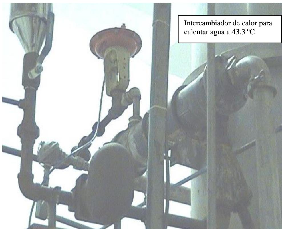
**FIGURA 1.7 CALENTADOR DE AGUA POTABLE DECLORADA**
