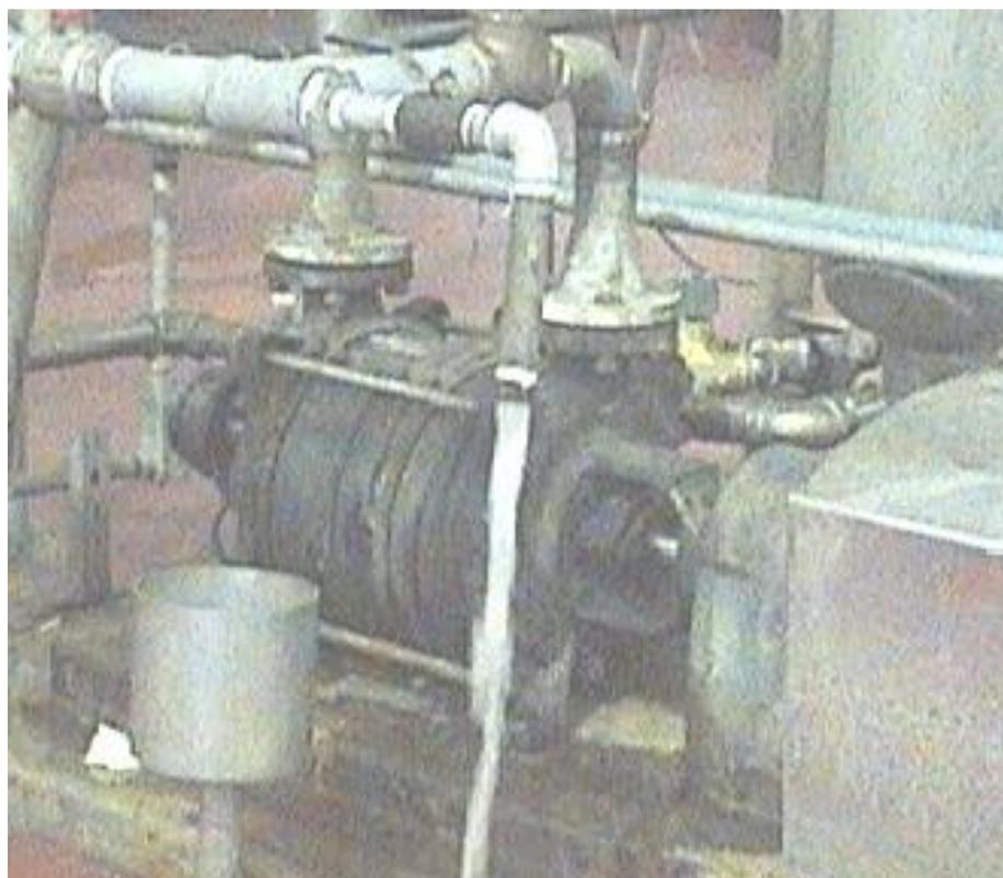
**FIGURA 2.1 DESPERDICIO DE AGUA POTABLE BOMBA DE VACIO.**
