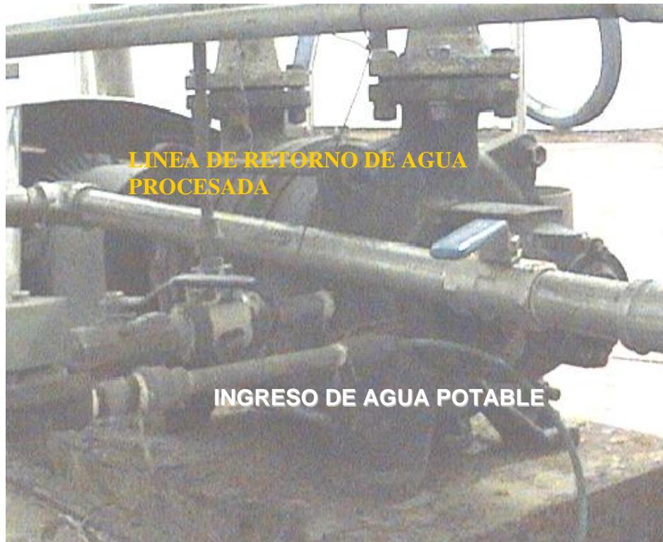
**FIGURA 2.10 INGRESO DE AGUA POTABLE A BOMBA DE VACIO.**
