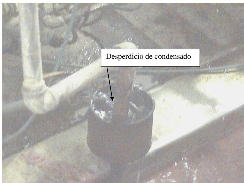
**FIGURA 1.10 DESPERDICIO DE CONDENSADO.**
