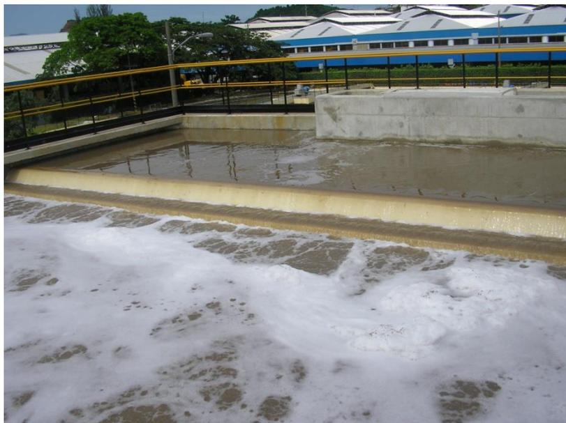
Tanque Anóxico alimentando a Tanque de Aireación
