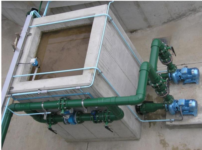
Tanque de lodos con sus accesorios y bombas de circulación.
