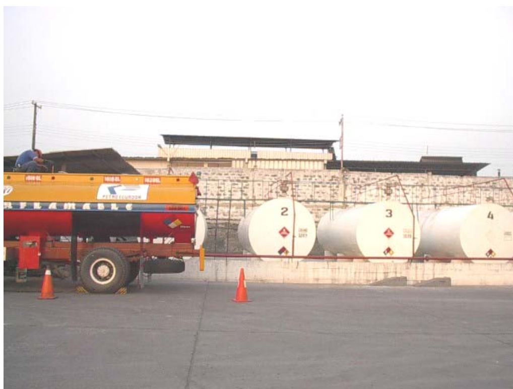
FIGURA 3-1. VISTA GENERAL DE LOS TANQUES A INSPECCIONAR
