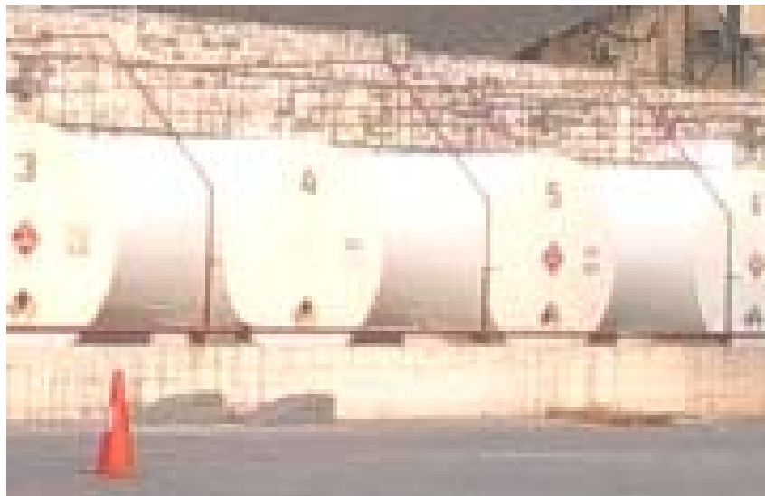
FIGURA 3-8. DISTANCIA DE TANQUE A CUBETO INADECUADO– TK 9
