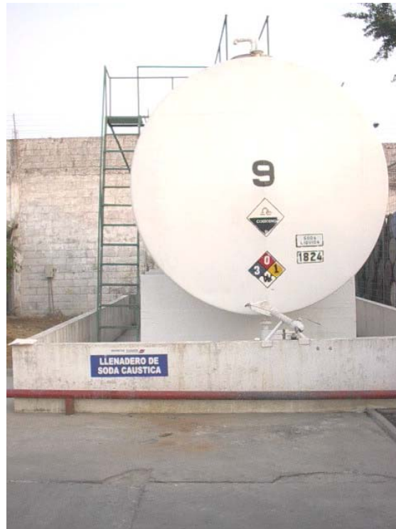
FIGURA 3-8. DISTANCIA DE TANQUE A CUBETO INADECUADO– TK 9
