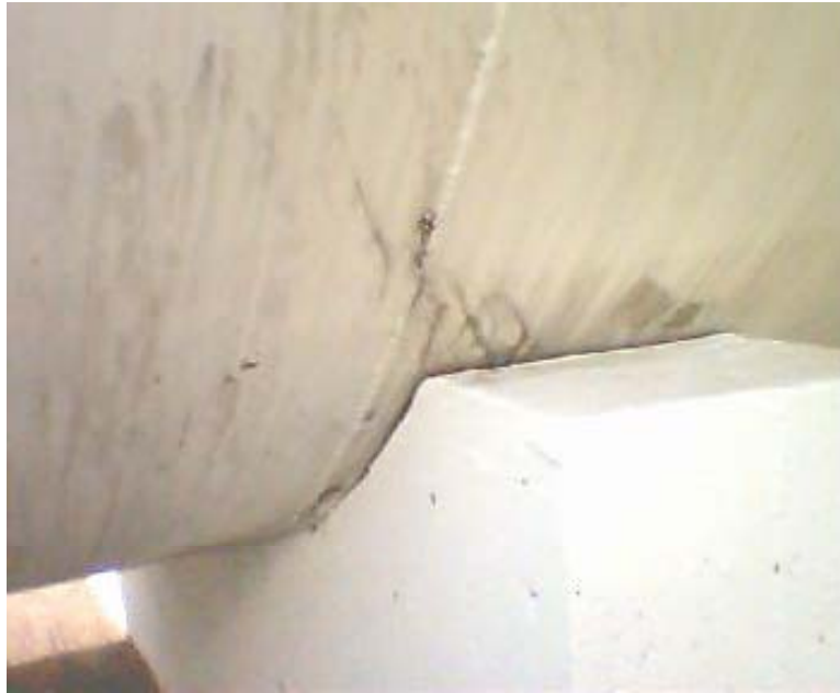
FIGURA 3-4. CORROSIÓN EN LAS SILLETAS DE SOPORTE- TK 2
