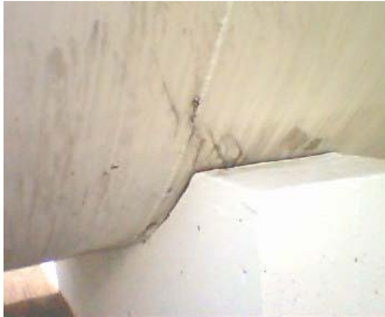
FIGURA 3-4. CORROSIÓN EN LAS SILLETAS DE SOPORTE- TK 2
