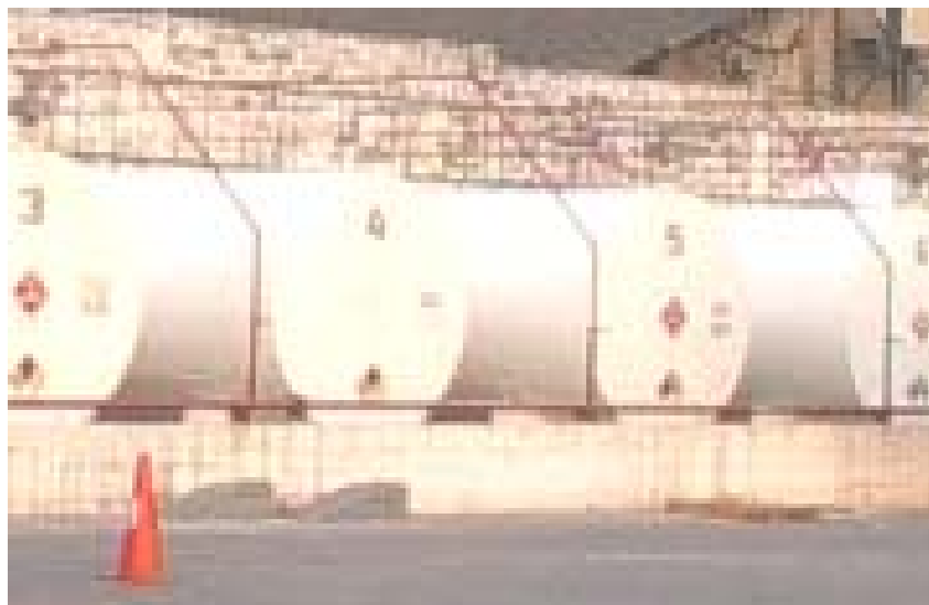
FIGURA 3-8. DISTANCIA DE TANQUE A CUBETO INADECUADO– TK 9
