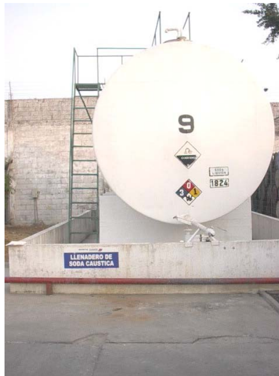
FIGURA 3-8. DISTANCIA DE TANQUE A CUBETO INADECUADO– TK 9
