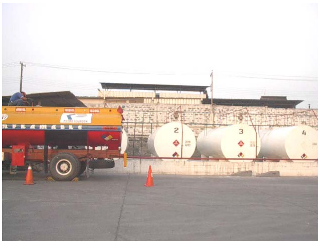
FIGURA 3-1. VISTA GENERAL DE LOS TANQUES A INSPECCIONAR
