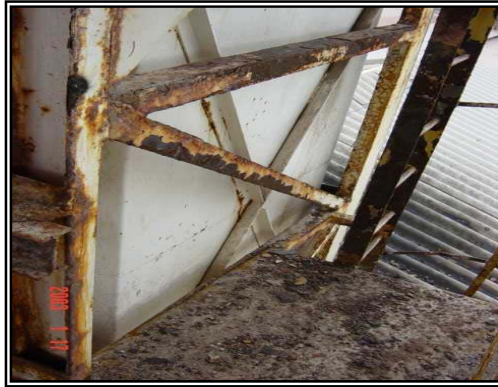
ESTRUCTURA DEL ELEVADOR
