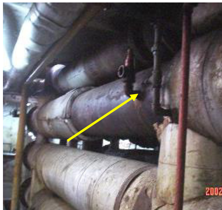
FIGURA 8.10 CALENTADORES DE JUGO DE CAÑA SECUNDARIOS CON SECCIONES SIN AISLAR
