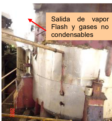
FIGURA 6.27 TANQUE DISTRIBUIDOR FLASH
