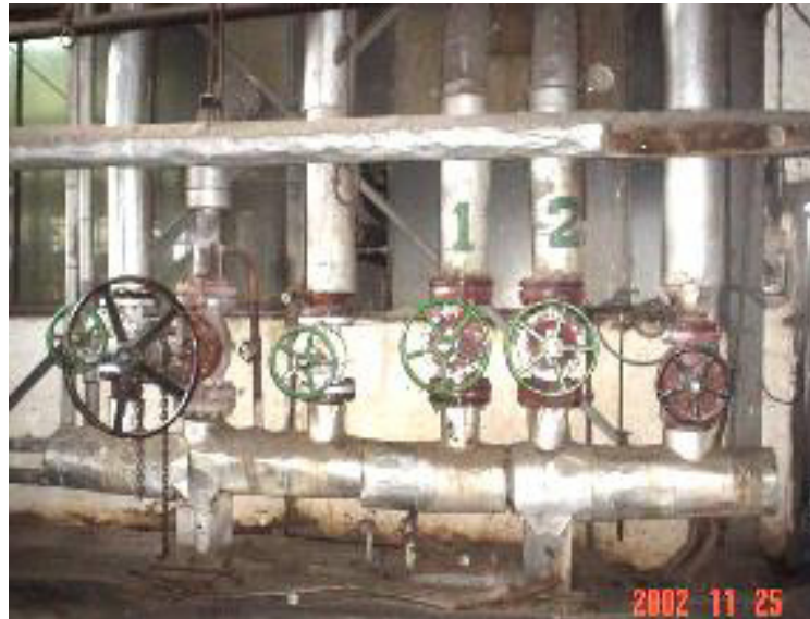
FIGURA 3.1. CABEZAL DE VAPOR TÍPICO
