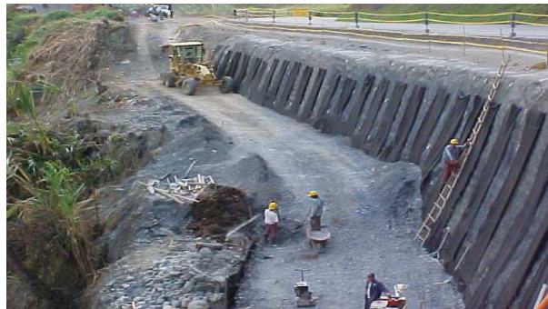
Figura 5.8 Colocación del Subdren en el espaldón
