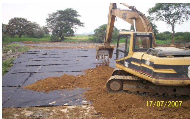
Figura 5.14 Colocación del Material de Relleno
