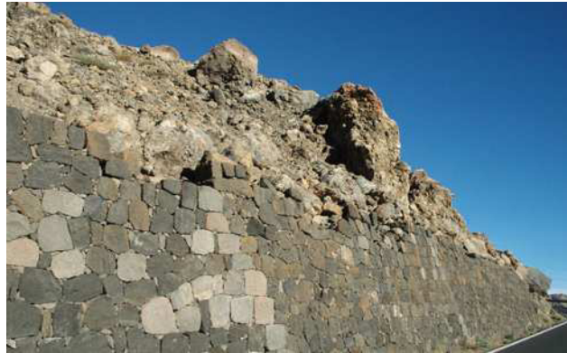
Fig.3.1 Muro de contención elaborado en roca
