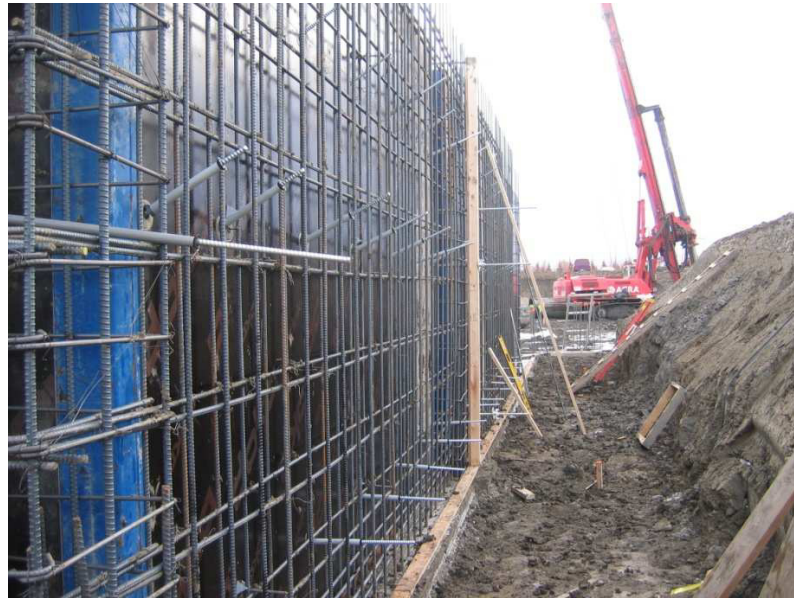
Figura 4.9 Figura de la colocación del acero de refuerzo en el muro HA
