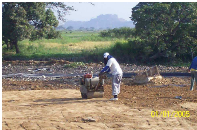
Figura 5.15 Compactación manual de la primera capa de relleno
