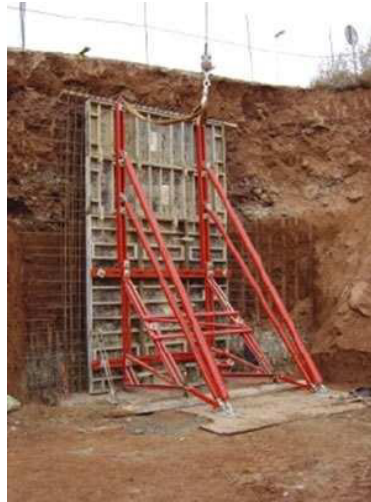
Figura 4.8 Figura de encofrado del muro de hormigón.
