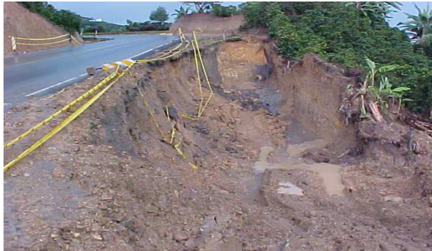
Figura 5.7 Preparación del terreno de Fundación
