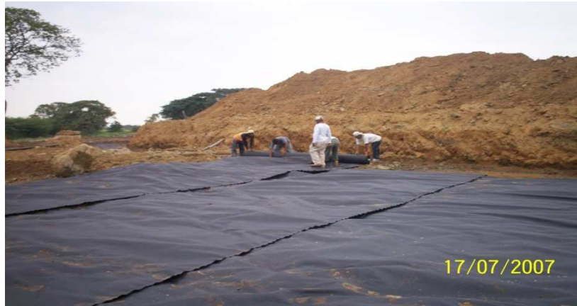
Figura 5.12 Colocación del Geotextil
