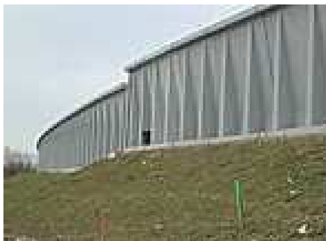
Fig.3.11 Muro con contrafuerte
