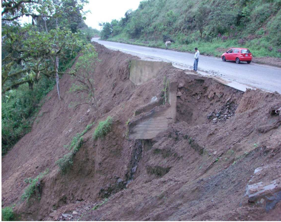
Fig.1.1.Deslizamiento lado derecho de la vía considerando que se recorre la vía desde Javin hacia Cochancay
