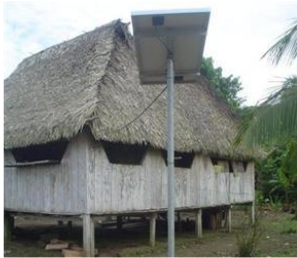
Figura 1. 4 Panel Fotovoltaico instalado en una comunidad 2
