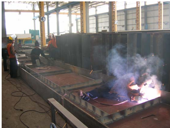
FIG. 3.2 PROCESO DE ARMADO DE LAS VIGAS (Cortesía Intermetal)
