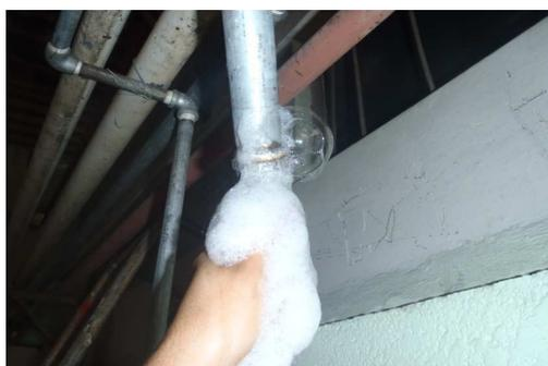
**FIG. 3.11 FUGA DE AIRE COMPRIMIDO EN LA LÍNEA**
