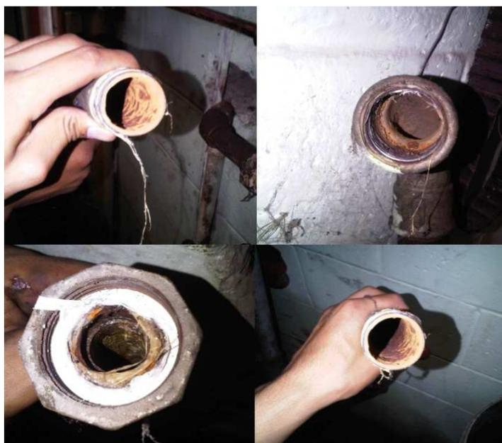
**FIG. 2.14 TUBERÍA DE AIRE COMPRIMIDO ACTUAL EN LAS ÁREAS DE TERMOFIJADORA Y FAK**
