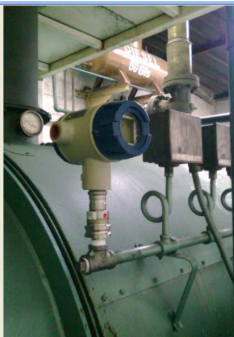
Transmisor de presión de vapor Honeywell modelo ST3000
