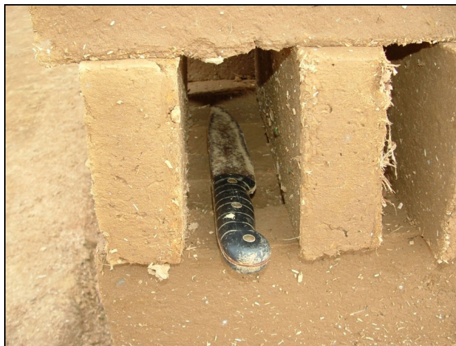
FIGURA 3.9. Rebabado de ladrillos con cuchillas
