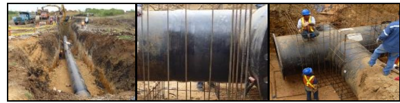
Figura 1. Instalación de tuberías
